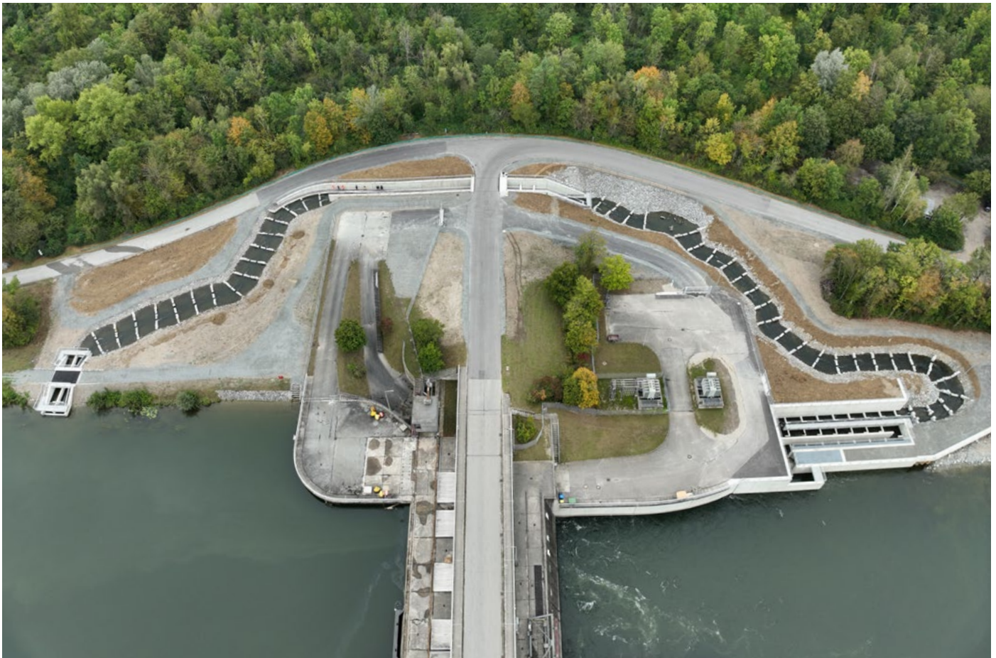
Fischaufstiegsanlage, Landau ad Isar, Deutschland
