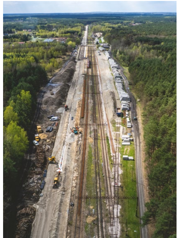
Streckensanierung Stalowa Wola – Tarnobrzeg – Sandomierz – Ocice, Polen
