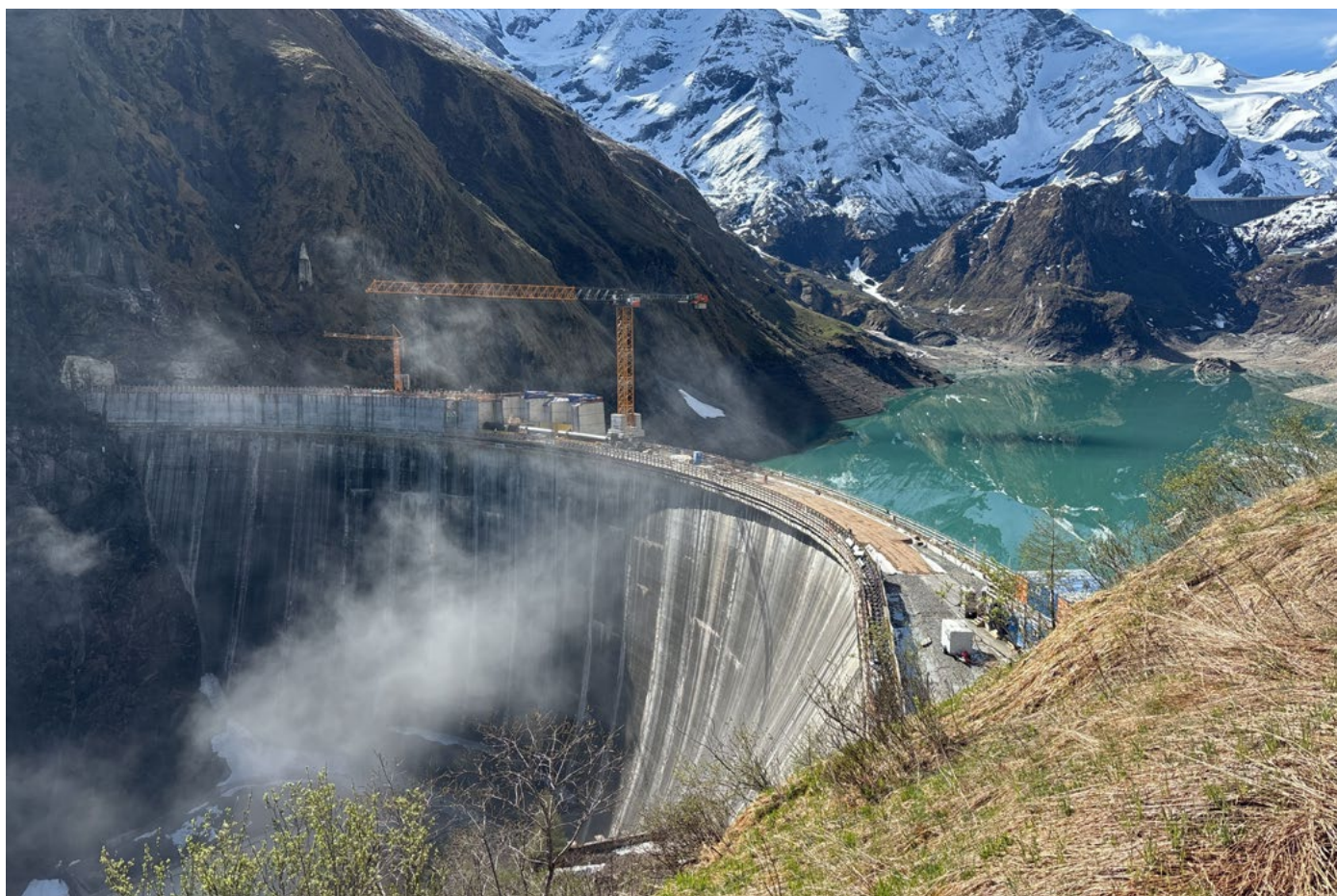
Erhöhung Talsperre Limberg 2, Kaprun, Österreich
